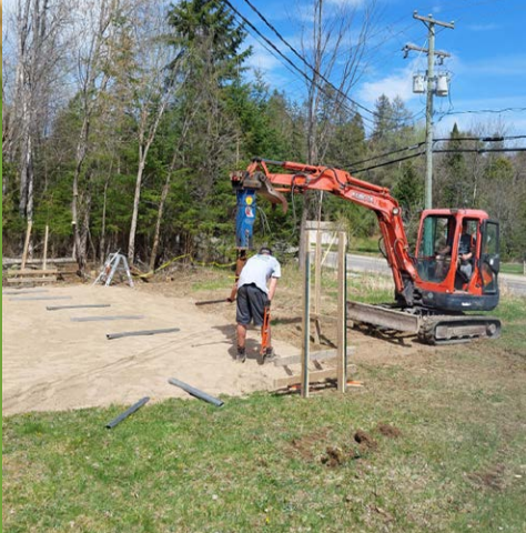
Installation des pieux des serres communautaires de Lac-Supérieur et Montcalm.
